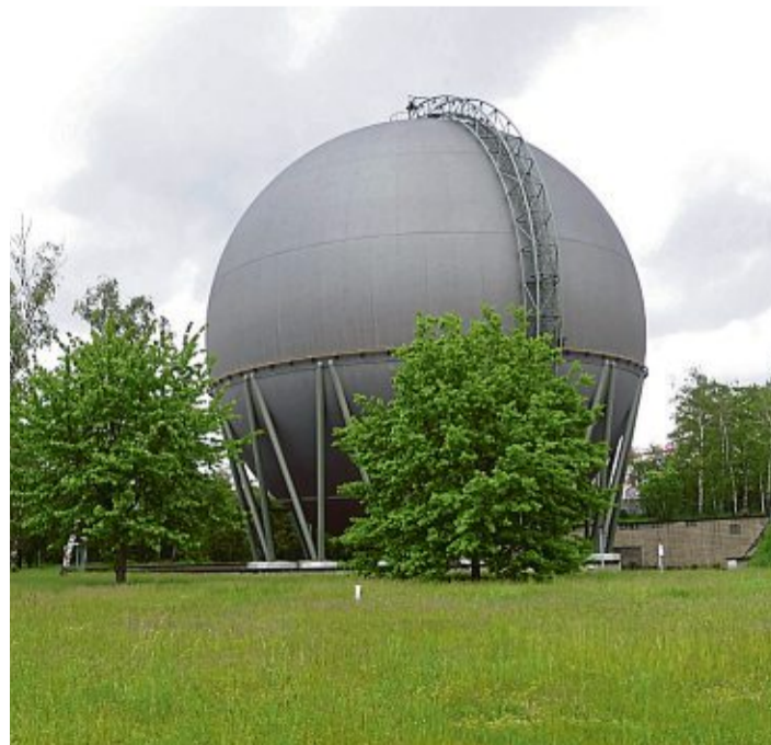
Der Kugelgasbehälter am Maarweg ist von einer Grünfläche umgeben. Auch die möchten Ehrenfelder Politiker erhalten wissen. Foto: Rösigen
