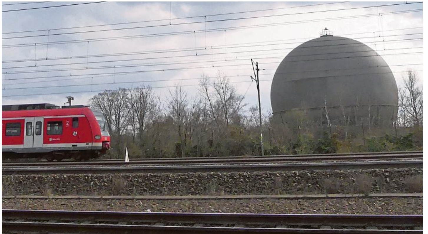
Direkt neben der Bahntrasse liegt die Gaskugel, deren Abbruch längst genehmigt ist.
